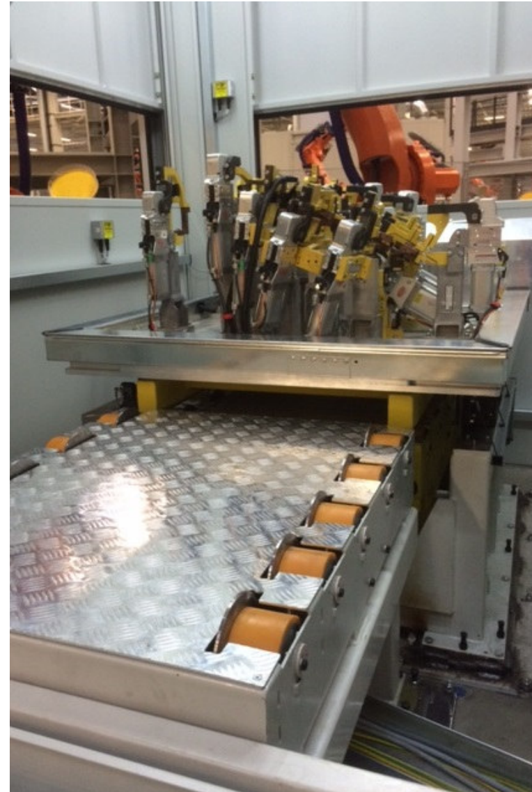
Blick über Rollenbahn in Bearbeitungsstation (Laserzelle)
